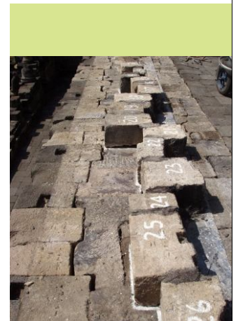
Susunan batu pada saat pembongkaran
