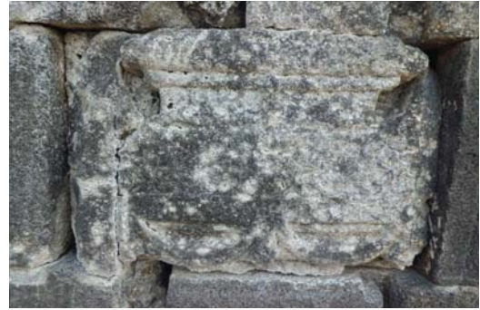
Gambar 4. Penggaraman pada batu Candi Borobudur
