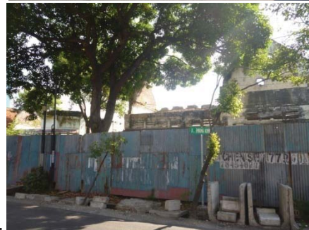
b. Gambar 10. (a) Rumah di Embong Kemiri no. 17 dengan kondisi tidak banyak berubah; dan (b) Kondisi rumah ketiga dan keempat yang mengalami kerusakan. (Sumber: koleksi foto pribadi)
