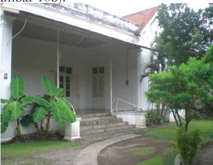
a. Gambar 8. (a) Tampak depan rumah no. 17 di Jalan Embong Kemiri; dan (b) Iklan berlatar warna kuning bertuliskan "Dijual" tergantung di pagar rumah no. 17. (Sumber: koleksi foto pribadi)
